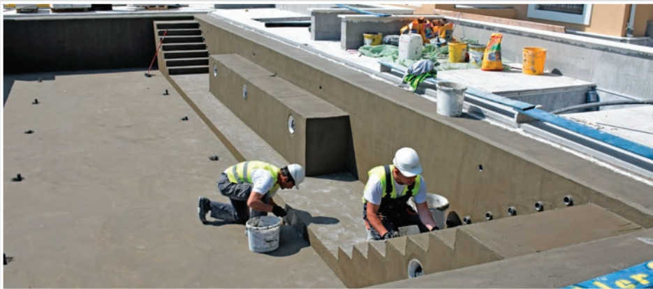
Installing SCHÖNOX 1K DS PREMIUM on moist concrete
