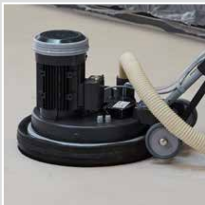
12 SCHÖNOX HS 50 avjämningsmassa kommer att ha härdat helt och vara klart för slipning efter cirka 12 timmar.
