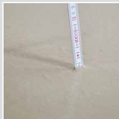
11 Hela systemet har en bygghöjd på endast 14 mm plus eventuellt ljudisolerande skikt.
